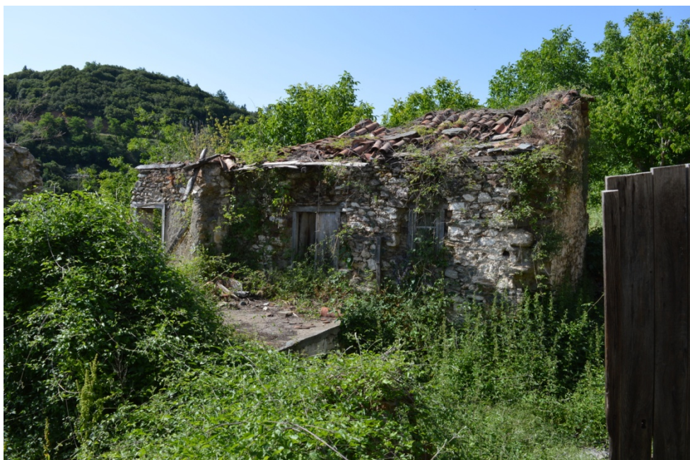
Σχ. 49. Παραδοσιακή ισόγεια κατοικία, εγκαταλελειμμένη, σε ερειπιώδη κατάσταση
