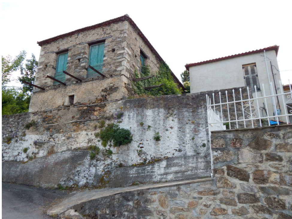
Σχ. 51. Παραδοσιακή κεραμοσκεπής διώροφη κατοικία σε μέτρια κατάσταση
