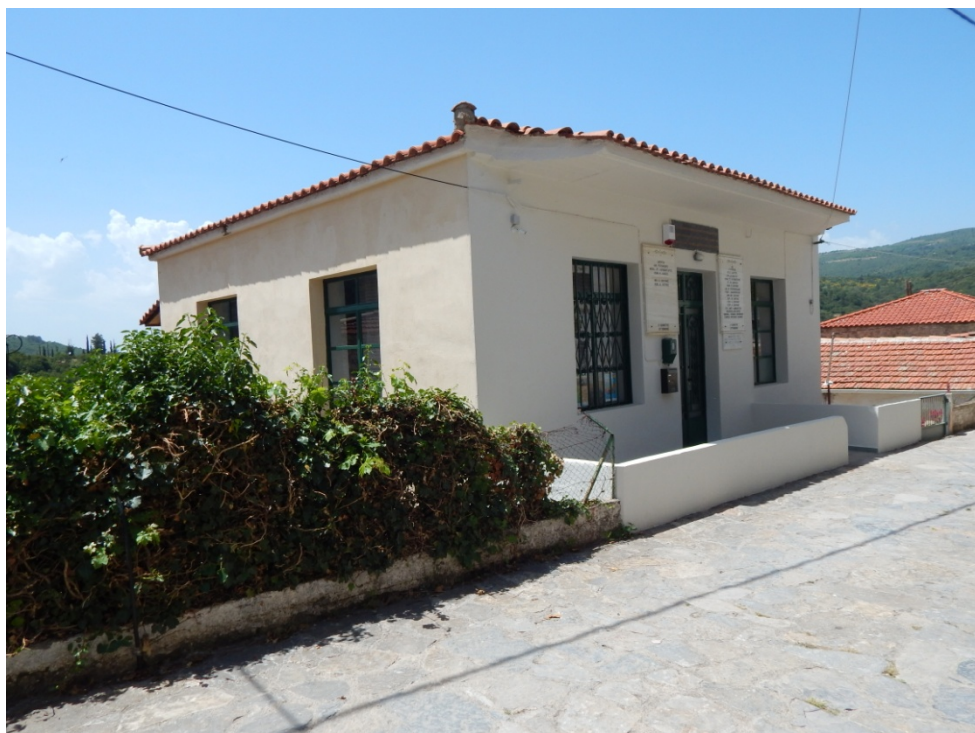
Σχ. 57. Μη παραδοσιακό κεραμοσκεπές δίδροφο κτήριο, κοινοτικής χρήσης, σε καλή κατάσταση
