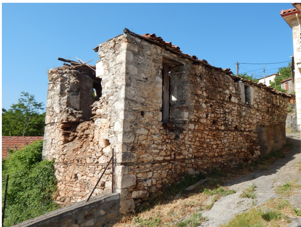
Σχ. 50. Παραδοσιακή ισόγεια κατοικία, εγκαταλελειμμένη, σε ερειπιώδη κατάσταση
