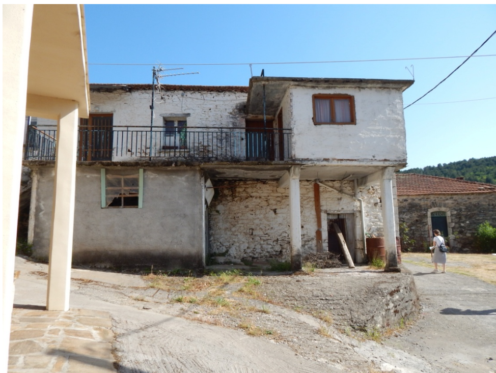
Σχ. 55. Παραδοσιακή, αλλοιωμένη, κεραμοσκεπής δώροφη κατοικία, με πλακοσκεπές τμήμα, σε μέτρια κατάσταση
