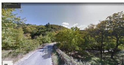
Σ2 γέφυρα – διασταύρωση με μονοπάτι
