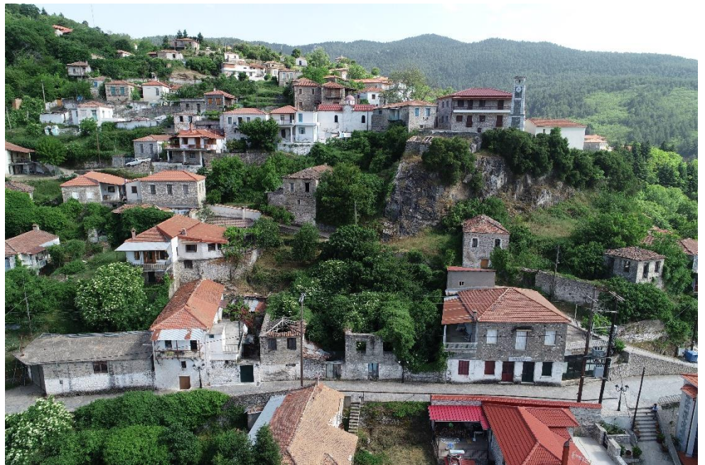
Εικ. 1.23 Ο κεντρικός δρόμος του οικισμού πριν την πλατεία. Διακρίνεται το μέτωπο των ερειπωμένων κτισμά- των και η σχέση του δρόμου με το πλάτωμα του ρολογιού
