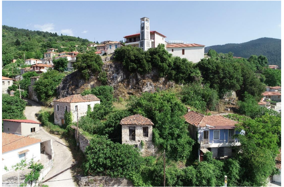
Εικ. 1.34 Η ενότητα ερειπωμένων κτισμάτων μεταξύ της πλατείας και του πλα- τώματος του ρολογιού
